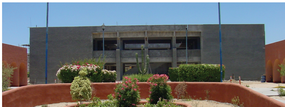
Construcción del edificio de Derecho, conocido coloquialmente en la Universidad como “Big Brother” (circa 2000)
